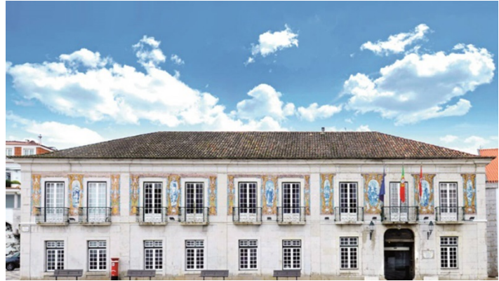
74. Museu da Vila: fachada principal.
