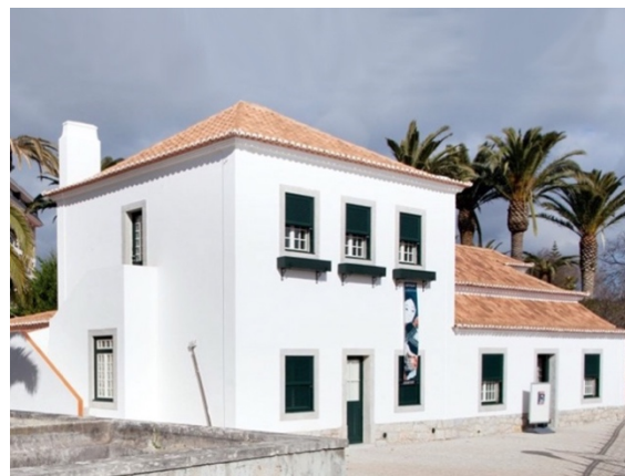
43. Fachada principal da Casa Duarte Pinto Coelho.
